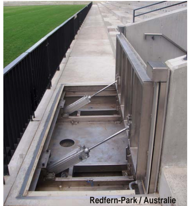
Système en état opérationnel
